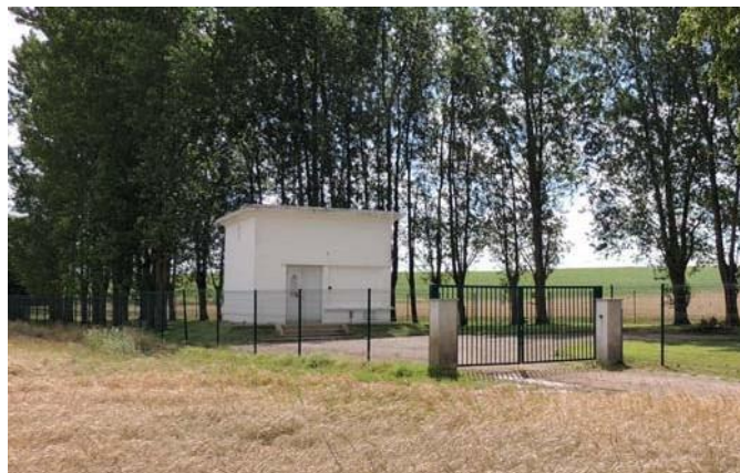
Protection du captage d'Eperlecques - © D. Devallez
