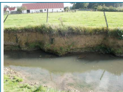
Erosion active surtout à l'aval
